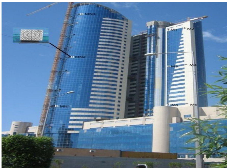
19 - сурет – Ғимараттағы бақылау маркаларының орналасуы
