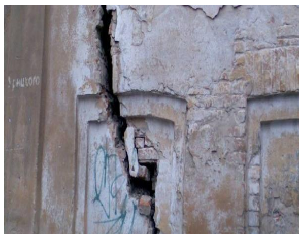
18 - сурет – Инженерлік құрылыстар деформациялануының әсерінен пайда болған жарықшақтар
