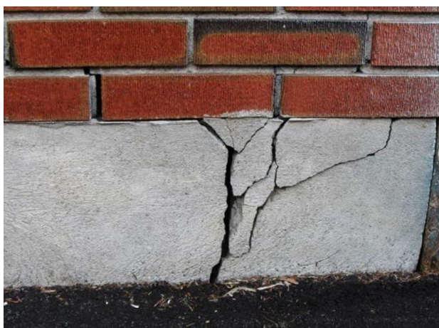
18 - сурет – Инженерлік құрылыстар деформациялануының әсерінен пайда болған жарықшақтар
